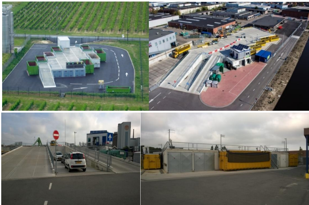
Rysunek 1 Przykładowe rozwiązania systemu rampowego
